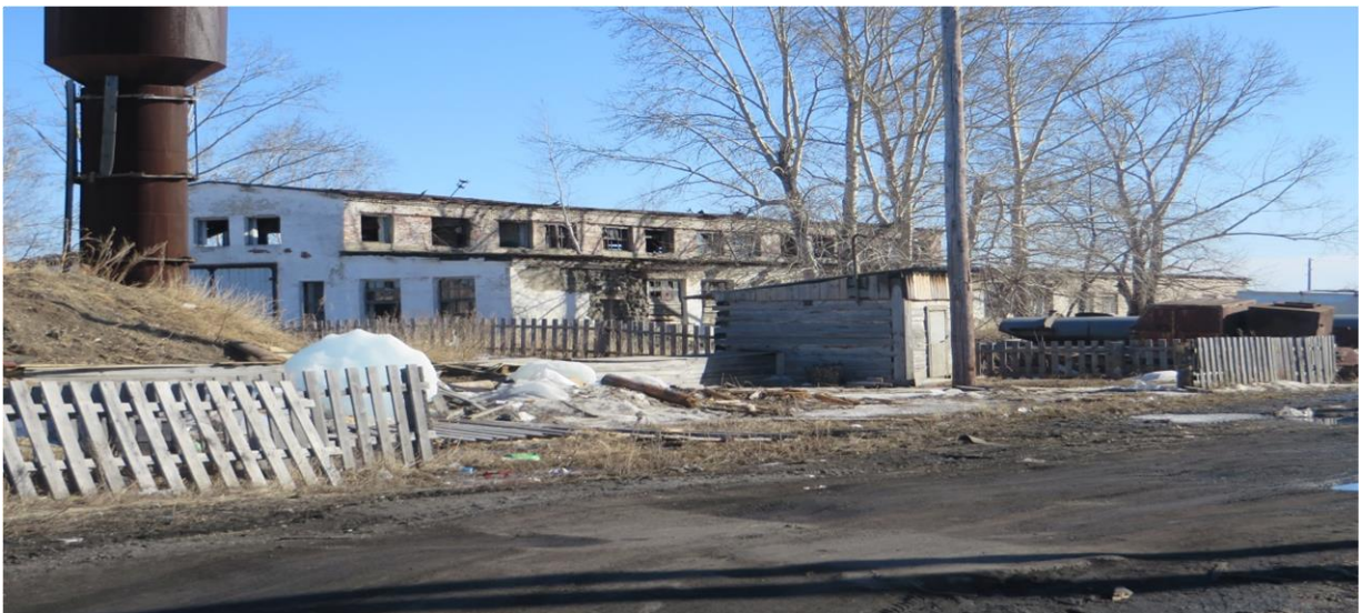
Рисунок 4. Скважина централизованного водоснабжения на ул. Гагарина, 94б
