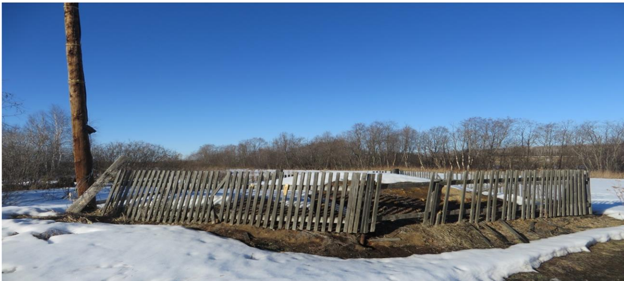
Рисунок 9. Скважина централизованного водоснабжения с.Измоденово
