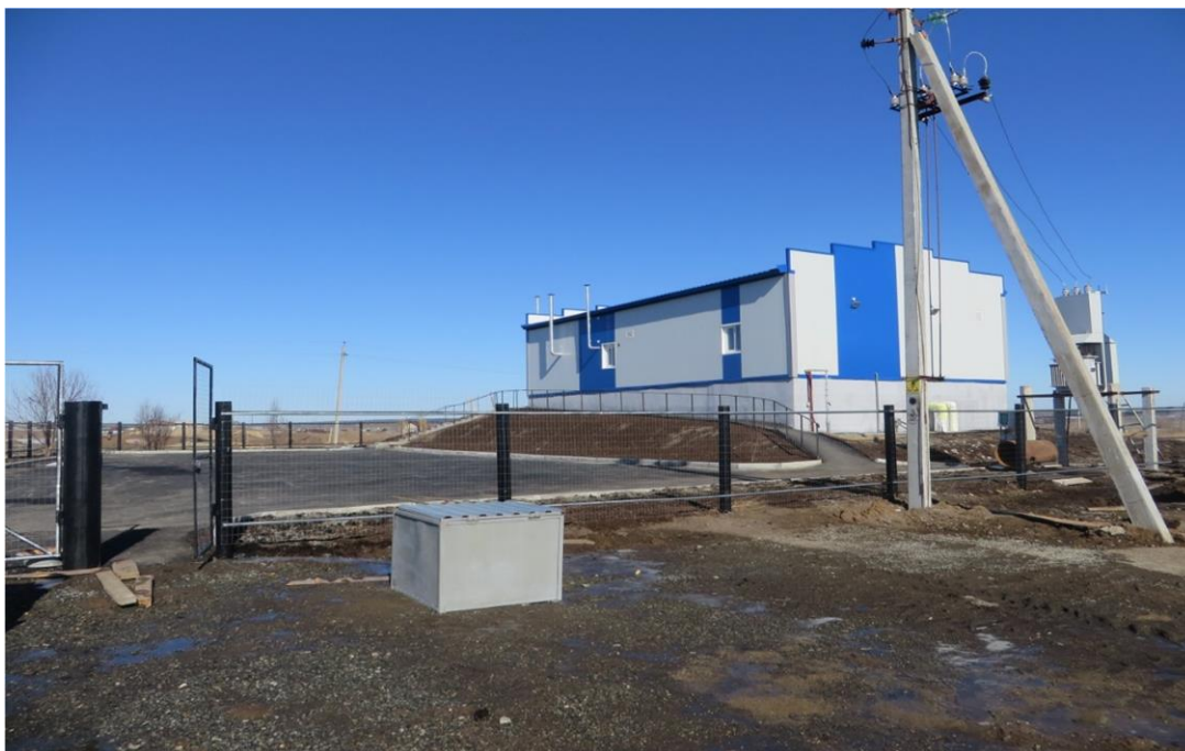
Рисунок 13. Общий вид очистных сооружений в п. Махнёво
