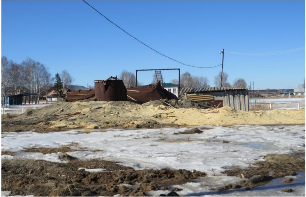
Рисунок 6. Скважина централизованного водоснабжения на ул. 70 лет Октября, 39в
