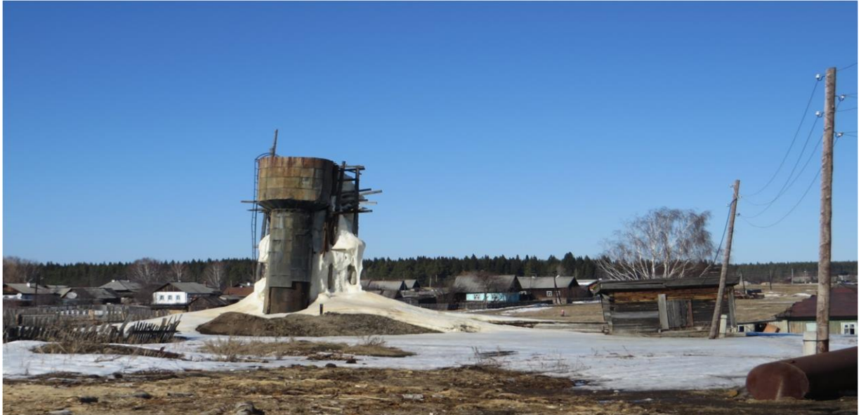
Рисунок 3. Скважина централизованного водоснабжения на ул. Профсоюзная, 1
