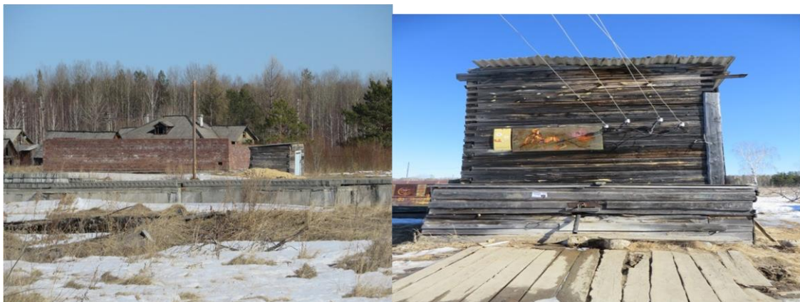
Рисунок 7. Скважина централизованного водоснабжения п.Хабарчиха
